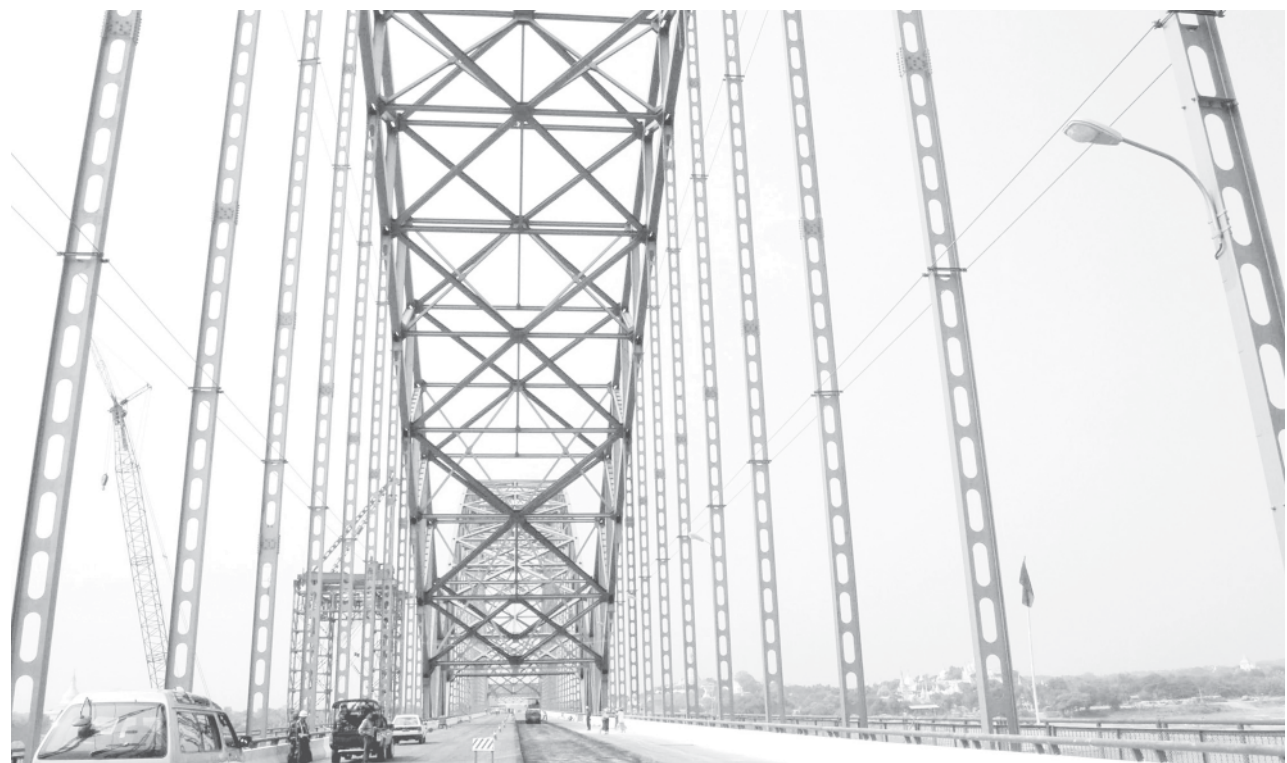
Ayeyawady Bridge (Yadanabon). — MNA
