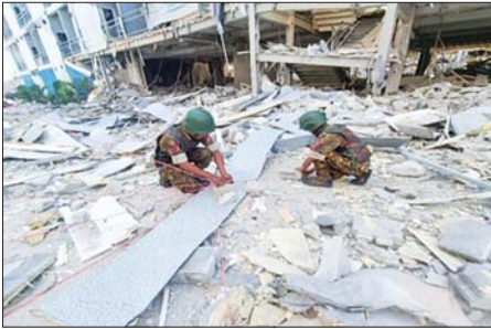
လူနေအဆောက်အအုံ လေးထပ် C 7 အား ဖောက်ခွဲရန် ယမ်း ၁၅၀ ကီလိုဂရမ်တပ်ဆင်နေစဉ်။
