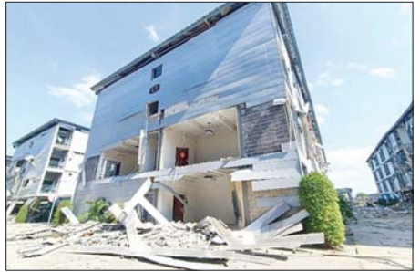
လူနေအဆောက်အအုံ လေးထပ် C 12 အား စနစ်တကျ ဖောက်ခွဲ ဖျက်ဆီးပြီး မြင်တွေ့ရစဉ်။
