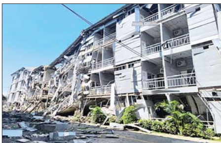
လူနေအဆောက်အအုံ လေးထပ် C 6 အား စနစ်တကျ ဖောက်ခွဲဖျက်ဆီးပြီး တွေ့ရစဉ်။
