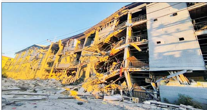
လူနေအဆောက်အအုံ လေးထပ် C 1 အား စနစ်တကျ ဖောက်ခွဲဖျက်ဆီးပြီး တွေ့ရစဉ်။
