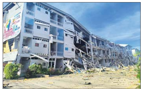
လူနေအဆောက်အအုံ လေးထပ် G 2 အား စနစ်တကျ ဖောက်ခွဲဖျက်ဆီးပြီး တွေ့ရစဉ်။
