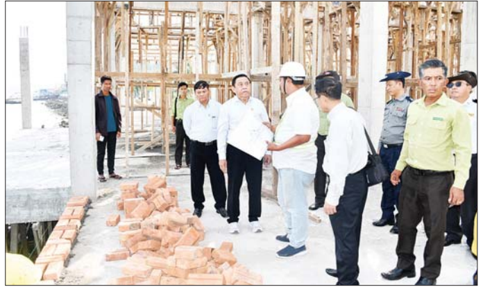
ကုမ္ပဏီမှ တာဝန်ရှိသူများက တည်ဆောက်ရေး လုပ်ငန်းဆောင်ရွက်ထားရှိမှု အခြေအနေများကို လုပ်ငန်းဆောင်ရွက်နေမှုနှင့် လုပ်ငန်းပြီးစီးမှုအခြေ လှည့်လည်ကြည့်ရှု၍ လိုအပ်သည်များ မှာကြားခဲ့ ကြောင်း သိရသည်။ တာဝန်ရှိသူများသည် အဆောက်အအုံအတွင်း ခရိုင် (ပြန်/ဆက်)
