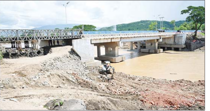
နိုင်ငံတော်စီမံအုပ်ချုပ်ရေးကောင်စီဥက္ကဋ္ဌ နိုင်ငံတော်ဝန်ကြီးချုပ် ဗိုလ်ချုပ်မှူးကြီး မင်းအောင်လှိုင် နှင့် နေရာထိုင်ခင်း (အဆင့်) ယာယီဘေလီတံတား တည်ဆောက်ပြုပြင်ပြီးစီးမှုနှင့် တံတားချဉ်းကပ်လမ်းကမ်းကပ်ခုံ ပြန်လည်ပြုပြင်ဆောင်ရွက်နေမှုကို ကြည့်ရှုစစ်ဆေးစဉ်။
