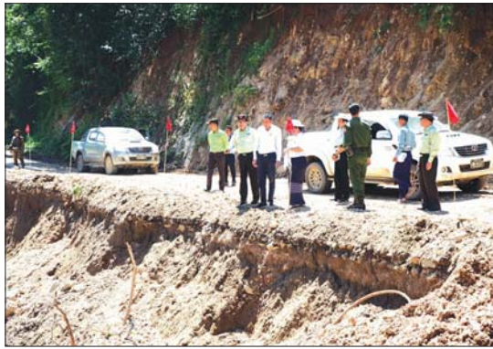
အရှည် ၅၆၀ မီတာ၊ သံကူကွန်ကရစ် ရှင်းလင်းဆောင်သို့ ရောက်ရှိရာ သံလွင်(တာဆွတ်တိန်း) တံတား အဆိုပါစီမံကိန်းလုပ်ငန်း တာဝန်ရှိသူ တည်ဆောက်ရေး စီမံကိန်းလုပ်ငန်း များက လုပ်ငန်းဆောင်ရွက်ပြီးစီးမှု ခရိုင်(ပြန်/ဆက်)
