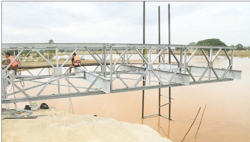
နိုင်ငံတော်စီမံအုပ်ချုပ်ရေးကောင်စီ ဒုတိယဥက္ကဋ္ဌ ဒုတိယဝန်ကြီးချုပ် ဒုတိယဗိုလ်ချုပ်မှူးကြီး စိုးဝင်း ရေတိုက်စားမှုကြောင့် ပျက်စီးသွားသည့် နဝင်းချောင်းတံတား (သာယာအေး)ကို ယာယီဘေးလိတ်တားအဖြစ် ပြန်လည်တည်ဆောက်နေမှုအား ကြည့်ရှုစစ်ဆေးစဉ်။
