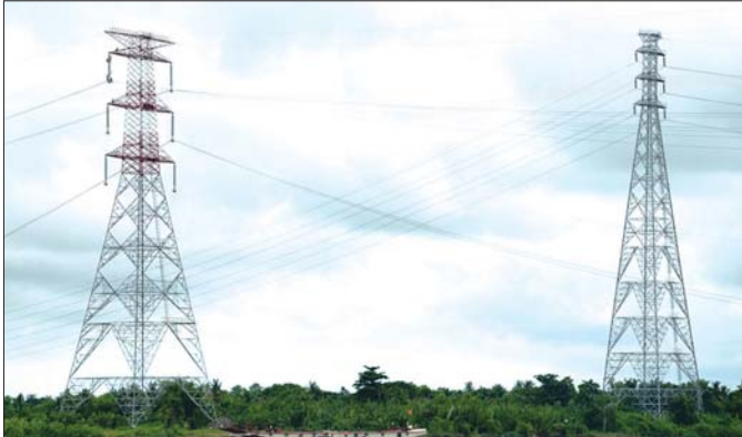
လျှပ်စစ်ဓာတ်အားပို့လွှတ်ရေးနှင့် ကွပ်ကဲရေးဦးစီးဌာနမှ ဆောင်ရွက်လျက်ရှိသည့် ၅၀၀ ကေစီ ဘုရားကြီး-လှိုင်သာယာ လှိုင်မြစ်ကျော် ဓာတ်အားလိုင်းသွယ်တန်းခြင်းလုပ်ငန်းကို တွေ့ရစဉ်။
