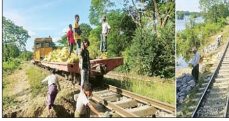
ရန်ကုန် - မန္တလေး ရထားလမ်းပိုင်း၊ မြစ်ငယ်နှင့် ပလိပ်ဘူတာအကြား ရထားလမ်းထူးပေါက်မှုကို ပြန်လည်ဖြုတ်ပြီးစီးမှုအခြေအနေ။
