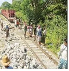
ရန်ကုန် - မန္တလေး ရထားလမ်းပိုင်း၊ မြစ်ငယ်နှင့် ပလိပ်ဘူတာအကြား ရထားလမ်းထူးပေါက်မှုကို ပြန်လည်ဖြုတ်ပြီးစီးမှုအခြေအနေ။
