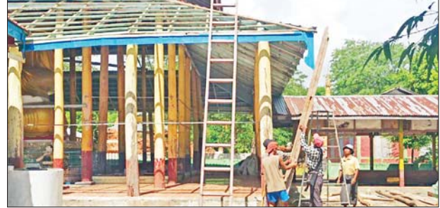
နှင့် ရှေးမူမပျက် ဆောင်ရွက်လျက်ရှိပြီး ကျန်သာသနိကအဆောက်အအုံ များကိုလည်း ပြန်လည်အသစ်တည်ထား ပြုပြင်သွားမည်ဖြစ်ကြောင်း သိရသည်။
