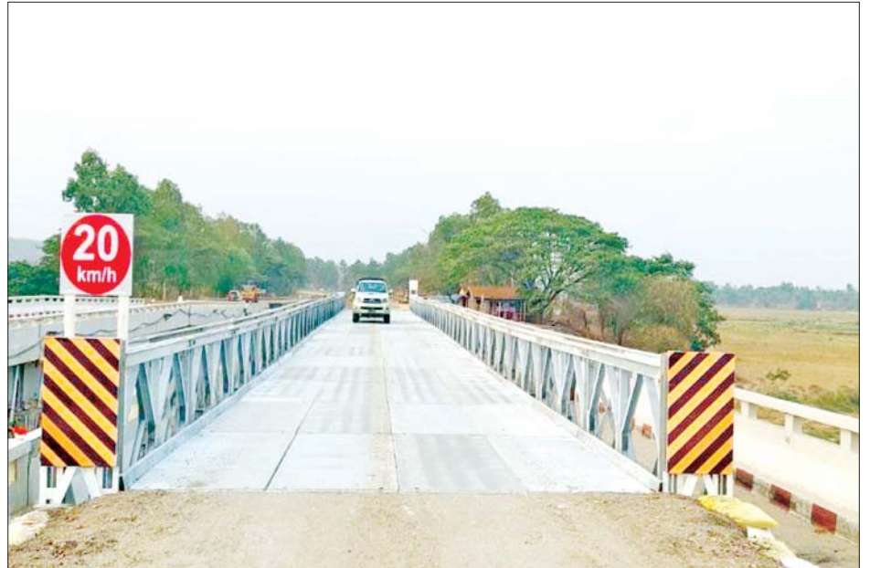
ငလျင်ဒဏ်ကြောင့် ဆွာချောင်းတံတား ထိခိုက်ပျက်စီးမှုအား ခရီးသွားပြည်သူများ အဆင်ပြေချောမွေ့စွာ သွားလာနိုင်ရေး ပြန်လည်တည်ဆောက်ရေးလုပ်ငန်းများ ဆောင်ရွက်ထားမှုကို တွေ့ရစဉ်။
