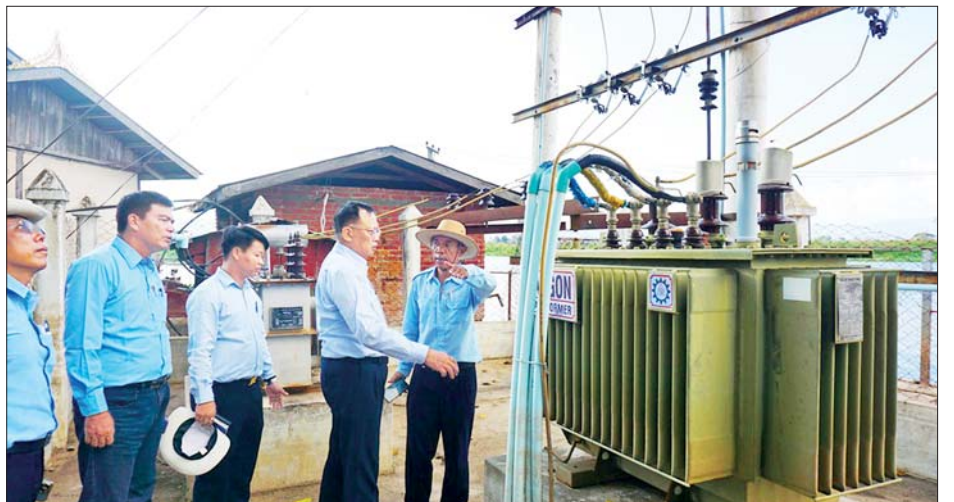
ပြန်လည်ထူထောင်ရေးလုပ်ငန်းများ အရှိန်အဟုန် မြှင့်ဆောင်ရွက်ပြီး စမ်းသပ်စစ်ဆေးမှုများ ပြုလုပ် ခဲ့ရာ နိုဝင်ဘာ ၂ ရက်တွင် ကျေးရွာ/ရပ်ကွက်ပေါင်း ၁၉၇ ရွာအား ဓာတ်အားပြန်လည်ဖြန့်ဖြူးပေးနိုင်ခဲ့ ပြီး ကျန်ရှိသော ကျေးရွာ/ရပ်ကွက်များကို ဓာတ်အား အမြန်ဆုံး ပြန်လည်ဖြန့်ဖြူးပေးနိုင်ရေး ကြိုးပမ်း ဆောင်ရွက်လျက်ရှိကြောင်း သိရသည်။ သတင်းစဉ်
