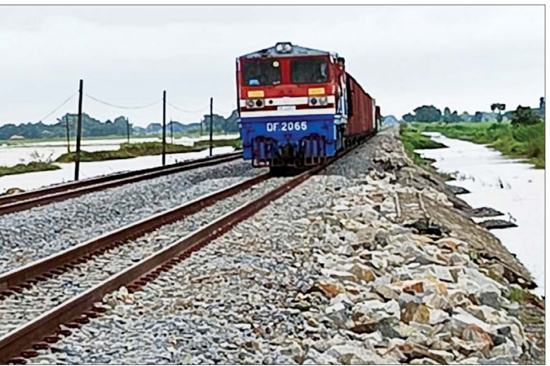
ရန်ကုန်-မန္တလေး ရထားလမ်းပိုင်း၊ ပဲခူး-ရွှေလှေအကြား ရထားလမ်းတာပေါင်ရေတိုက်စားထားသော နေရာများအား ကျောက်ကြီးများချလှူထည့်ပြုပြင်ပြီးစီးမှုကို တွေ့ရစဉ်။
