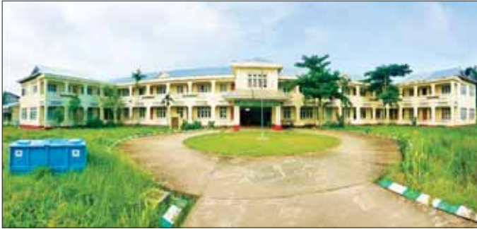
အထက - ရသေ့တောင် ပြုပြင်ပြီးစီးမှု ရသေ့တောင်မြို့နယ်၌ အလွန်အလွန်အားကောင်းသော မိုခါဆိုင်ကလုန်းမုန်တိုင်းကြောင့် ပျက်စီးသွားသည့် အထက-ရသေ့တောင် ကျောင်းဆောင်သစ် (၃၂၂' x ၃၀') RCC နှစ်ထပ်ကျောင်းဆောင် ပြန်လည်ပြုပြင်ပြီးစီးမှုကို တွေ့ရစဉ်။
