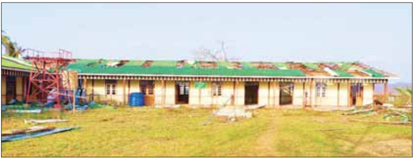
အထက(ခွဲ) ကံပြင် (၁) ထိခိုက်ပျက်စီးခဲ့ရ ရေသေ့တောင်မြို့နယ်၌ အလှူအလှူအားကောင်းသော မိုခါဆိုင်ကလုန်းမုန်တိုင်း ကြောင့် ပျက်စီးသွားသည့် အထက(ခွဲ) ကံပြင် (၁)၊ အဆောင်(၁) (၁၈၀' x ၃၀') အုတ်ညှပ် တစ်ထပ်ကျောင်းဆောင် ထိခိုက်ပျက်စီးမှုကို တွေ့ရစဉ်။
