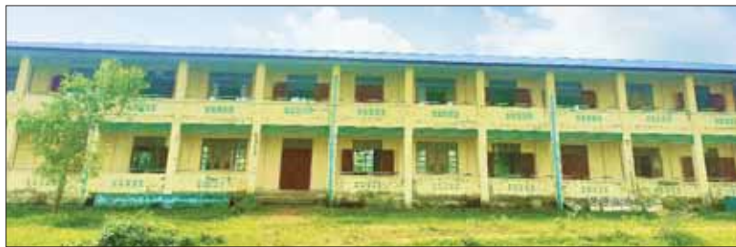
အထက - ကူတောင် ပြုပြင်ပြီးစီး မိုခါဆိုင်ကလုန်းမုန်တိုင်းကြောင့် ပျက်စီးသွားသည့် အထက - ကူတောင်၊ အဆောင်(၇) (၁၄၄' x ၃၀') RCC နှစ်ထပ်ကျောင်းဆောင် ပြန်လည်ပြုပြင်ပြီးစီးမှုကို တွေ့ရစဉ်။
