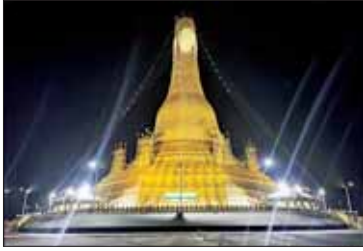
ကျိုက်ပညာယု စေတီတော်မြတ်ကြီး အလယ်ပစ္စယာ ရင်ပြင်တော်တွင် ဆလိုက်မီးများ တပ်ဆင်ဆောင်ရွက် ထားမှု။
