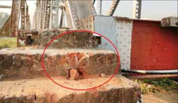
အကြမ်းဖက်သောင်းကျန်းသူများ၏ မိုင်းဖောက်ခွဲဖျက်ကြောင့် ရန်ကုန် - မန္တလေး ရထားလမ်းပိုင်း တောင်ငူ - သောင်းတိုင်ကုန်းဘူတာအကြား တံတားအမှတ် (၂၆၃) ခပေါင်းတံတား ပျက်စီးဆုံးရှုံးမှုအခြေအနေကို တွေ့ရစဉ်။
