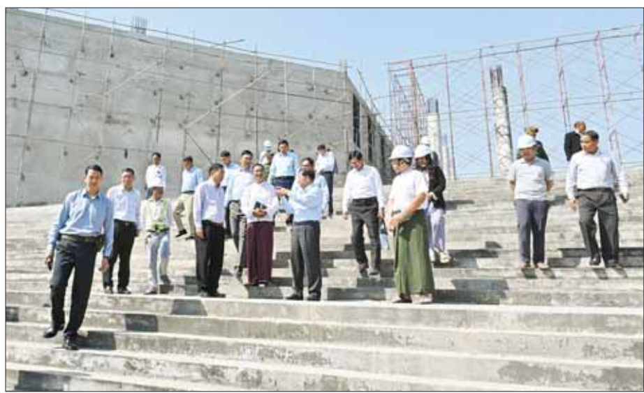
နိုင်ငံတော်စီမံအုပ်ချုပ်ရေးကောင်စီဥက္ကဋ္ဌ နိုင်ငံတော်ဝန်ကြီးချုပ် ဗိုလ်ချုပ်မှူးကြီး မင်းအောင်လှိုင် ရန်ကုန်အနောက်ပိုင်း နည်းပညာတက္ကသိုလ်အတွင်း သုံးထပ်စာသင်ဆောင်သစ် တည်ဆောက်နေမှုအခြေအနေများ ကြည့်ရှုစစ်ဆေးစဉ်။
