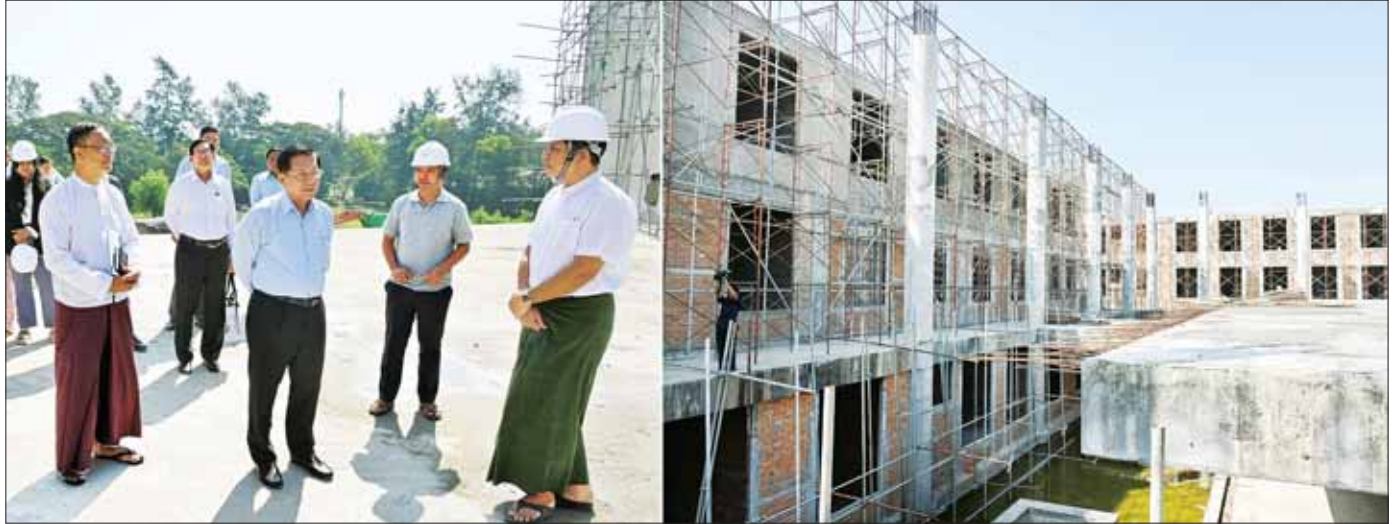
နိုင်ငံတော်စီမံအုပ်ချုပ်ရေးကောင်စီဥက္ကဋ္ဌ နိုင်ငံတော်ဝန်ကြီးချုပ် ဗိုလ်ချုပ်မှူးကြီး မင်းအောင်လှိုင် ရန်ကုန်အနောက်ပိုင်း နည်းပညာတက္ကသိုလ်အတွင်း သုံးထပ်စာသင်ဆောင်သစ် တည်ဆောက်နေမှုအခြေအနေ များကို ကြည့်ရှုစစ်ဆေးစဉ်။
