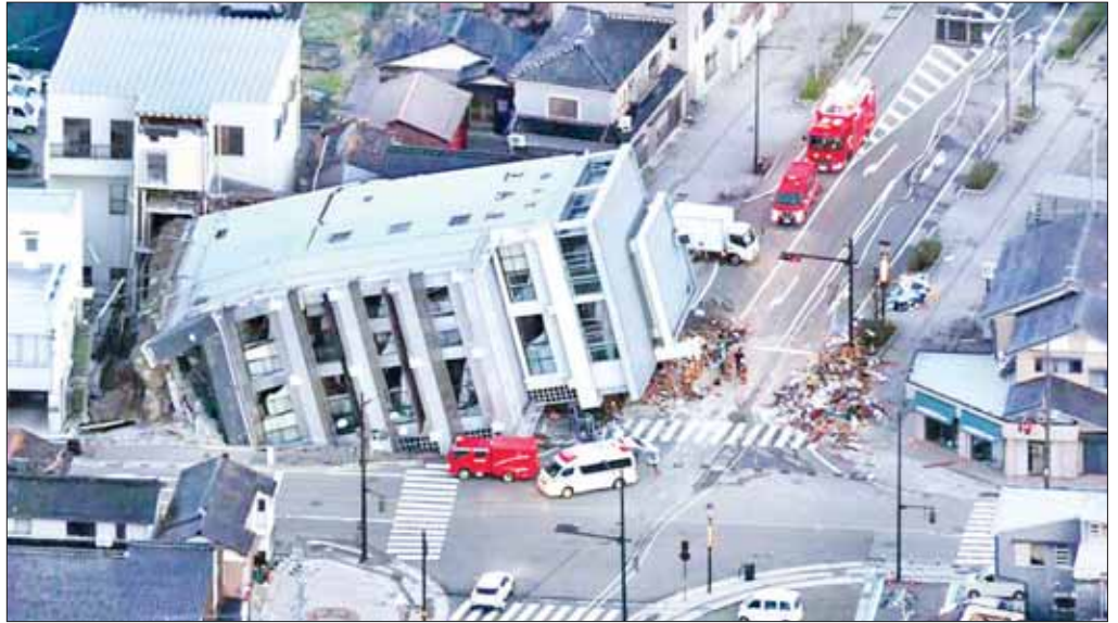
ဝါဂျီးမားမြို့တွင် ငလျင်လှုပ်မှုကြောင့် အဆောက်အအုံပြိုကျပျက်စီးနေသည်ကို တွေ့ရစဉ်။
