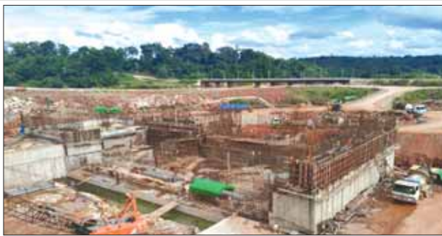
ဓာတ်အားပေးစက်ရုံ သံကူကွန်ကရစ်လုပ်ငန်း ဆောင်ရွက်စဉ်။
