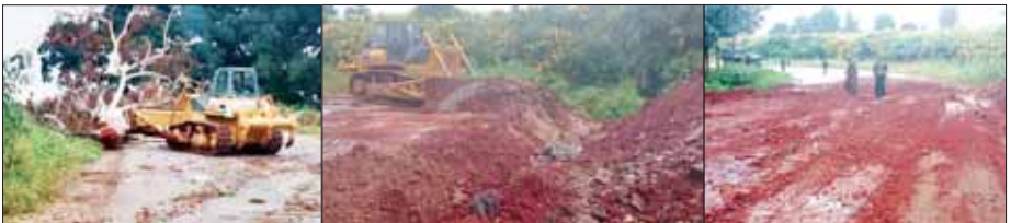
နောင်ပစ်နှင့် နောင်ပိန်းကျေးရွာကြားတွင် သစ်ပင်ကြီးများ ခုတ်လှဲပိတ်ဆို့ထားခြင်းကို ဖယ်ရှားနေမှုနှင့် ဖြတ်မြောင်းကြီးများ ပြုလုပ်ထားမှုကို ပြန်လည်ပြုပြင်ပြီးနောက် တွေ့ရစဉ်။
