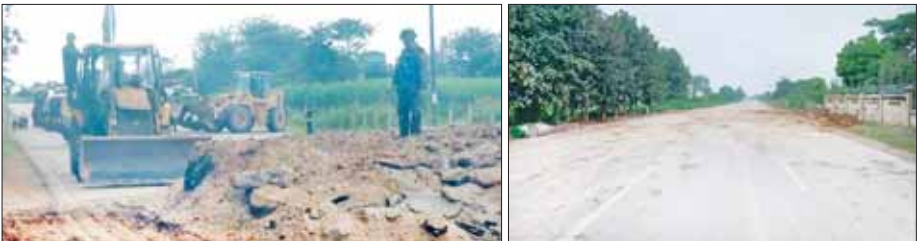
မြေဖြတ်ကျင်းများတူး၍ လမ်းဖြတ်တောက်တားဆီးထားမှုကို ရှင်းလင်းပြုပြင်စဉ်နှင့် ရှင်းလင်းပြီးနောက် တွေ့ရစဉ်။
