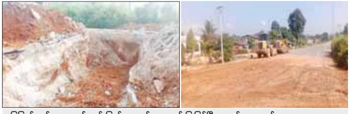
မြေဖြတ်ကျင်းများတူး၍ လမ်းဖြတ်တောက်ထားမှုနှင့် ပြုပြင်ပြီးနောက် တွေ့ရစဉ်။
