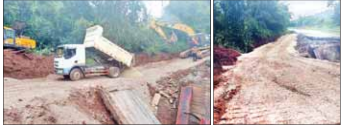
နောင်ပစ်လမ်းခွဲ၌ မြေဖြတ်ကျင်းများတူး၍ တားဆီးထားမှုကို လမ်းပြန်လည်အသုံးပြုနိုင်ရန် ဆောင်ရွက် နေမှုနှင့် ဆောင်ရွက်ပြီးနောက် တွေ့ရစဉ်။
