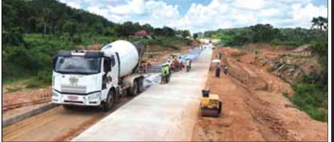
ပဲခူးအနောက်မြို့ရောင်လမ်းမှ ရန်ကုန် - မန္တလေး အမြန်လမ်းမကြီး မိုင်တိုင် (၃၂/၆-၇) လသာကုန်း Under Pass ကို ဆက်သွယ်ပေးမည့် လမ်းအရှည် ရှစ်မိုင် တစ်ဖာလုံအား ၂၄ ပေအကျယ် ကွန်ကရစ်လမ်းခင်းခြင်းလုပ်ငန်းများ ဆောင်ရွက်နေမှု။
