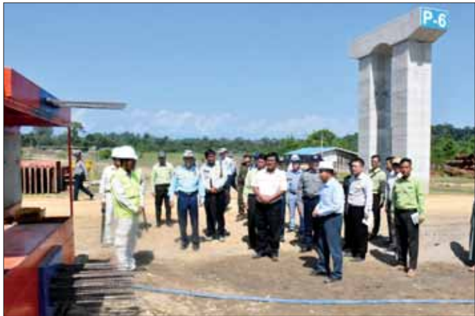
ကင်းလွတ်အမြင့်ပေ ၄၀ (HFL)ဖြင့် တည်ဆောက်နေခြင်း ဖြစ်သည်။ ထို့နောက် တိုင်းဒေသကြီးဝန်ကြီးချုပ်နှင့် တာဝန် ရှိသူများက ချင်းတွင်းမြစ်ကူးတံတား(ထမံသီ) ချဉ်းကပ်လမ်းဖောက်လုပ်နေမှုနှင့် တံတားကြီး တည်ဆောက်နေမှုလုပ်ငန်းများကို ကြည့်ရှုစစ်ဆေး ခဲ့ကြပြီး တည်ဆောက်ရေးလုပ်ငန်းများနှင့် ပတ်သက် သည့်များကို တာဝန်ရှိသူများကို မှာကြားခဲ့ကြောင်း သိရသည်။ တိုင်းဒေသကြီး(ပြန်/ဆက်)
