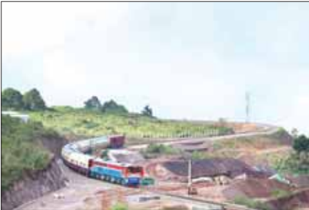
ရထားလမ်းဖောက်လုပ်ရာတွင် လမ်းပိုင်းနေရာအချို့၌ ကျောက်သားမြေခံရုံများ၊ ကျောက်တောင်များကို ဖြတ်တောက်တူးဖော်၍ ကျောက်တောင်ကြား လမ်းပိုင်းရှည်နေရာများ ခက်ခက်ခဲခဲ ကြိုးပမ်းဖောက်လုပ်ထားမှုကို တွေ့ရစဉ်။
