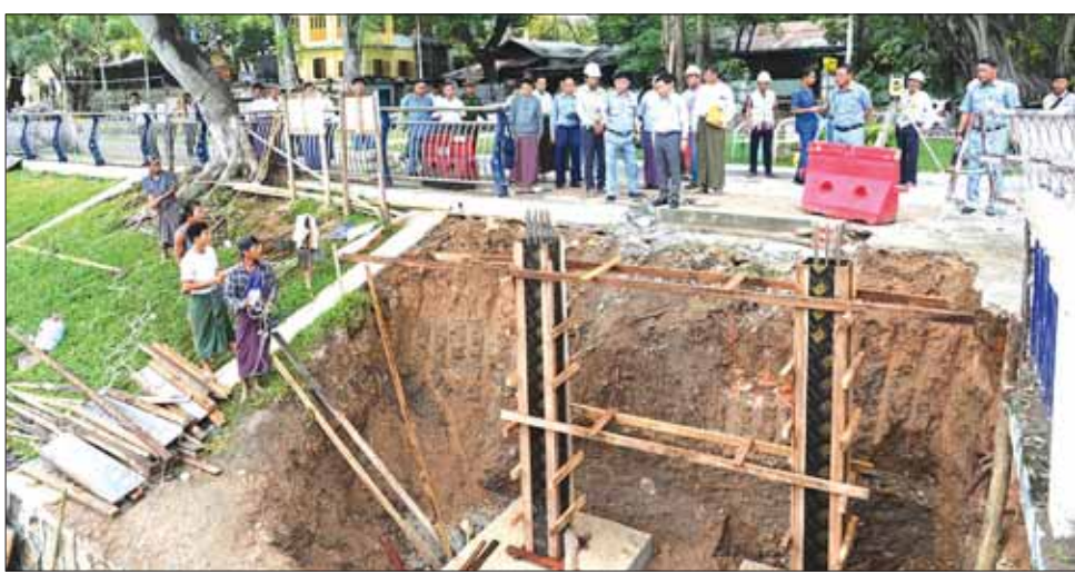
ဥက္ကဋ္ဌ၊ မြို့တော်ဝန်နှင့် တာဝန်ရှိသူများသည် ကန်တော်မင်္ဂလာရှမ်းကန်အတွင်း ရေလယ်ဘုရားကျောင်းဆောင် တည်ဆောက်သည့်အတွက် လူကူးလျှောက်လမ်းတံတားအသစ် တည်ဆောက်ရန်အတွက် ကွန်ကရစ်ရစ်ပိုင်ရိုက်ခြင်းလုပ်ငန်းဆောင်ရွက်နေမှု၊ ကန်ပတ်ဝန်းကျင်သာယာလှပစေရန်
