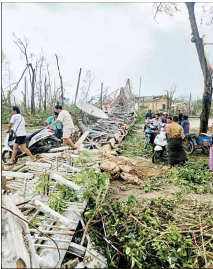
မိုခါမုန်တိုင်းဒဏ်ကြောင့် ကျိုးကျပျက်စီးခဲ့သော 100 Meter Self Supporting Tower တိုင်။
