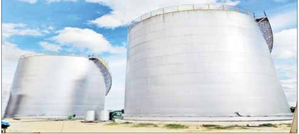
စစ်ကိုင်းတိုင်းဒေသကြီးအတွင်း အကောင်အထည်ဖော်နေသည့် အီသနောတန်ချိန်ငါးသောင်းထွက် စက်ရုံစီမံကိန်းမှ အီသနောသိုလှောင်ကန်ကြီးများ တည်ဆောက်ပြီးစီးနေမှုကို တွေ့ရစဉ်။
