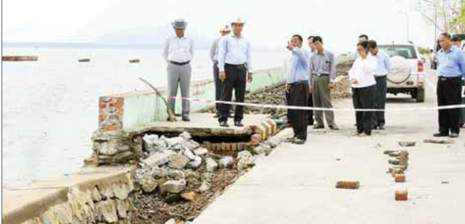
အား ဆောက်လုပ်ရေးဝန်ကြီးဌာန စစ်တွေခရိုင် လမ်းဦးစီးဌာနက ပြန်လည်ပြုပြင်ရန် ဆောင်ရွက်နေမှုအခြေအနေကို ကြည့်ရှုစစ်ဆေးသည်။ (အပေါ်ပုံ)
