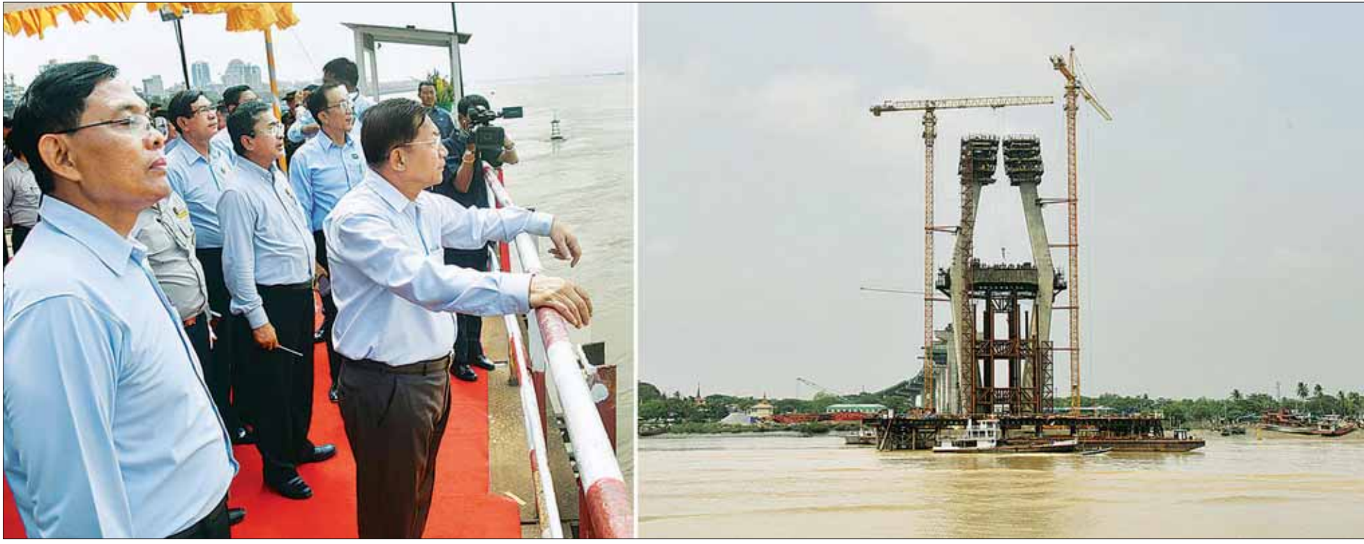
နိုင်ငံတော်စီမံအုပ်ချုပ်ရေးကောင်စီဥက္ကဋ္ဌ နိုင်ငံတော်ဝန်ကြီးချုပ် ဗိုလ်ချုပ်မှူးကြီး မင်းအောင်လှိုင် မြန်မာ - ကိုရီးယား ချစ်ကြည်ရေး (ဒလ) တံတားတည်ဆောက်ရေးစီမံကိန်းရှိ ရန်ကုန်ဘက်ခြမ်း Main Bridge Pylon 2 နေရာတွင် လုပ်ငန်းဆောင်ရွက်နေမှု အခြေအနေများကို ကြည့်ရှုစစ်ဆေးစဉ်။
