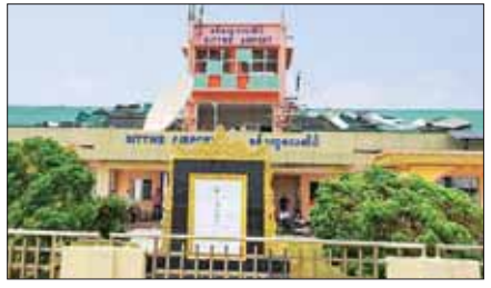
မေ ၁၄ ရက်က ဆိုင်ကလုန်းမုန်တိုင်း “မိုခါ” လေပြင်းတိုက်ခတ်မှု အရှိန်ကြောင့် ရခိုင်ပြည်နယ် စစ်တွေလေဆိပ်၌ ထိခိုက်ပျက်စီးမှုကို တွေ့ရစဉ်။ (ပြန်/ဆက်)
