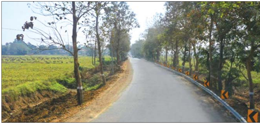
၂၀၂၂-၂၀၂၃ ဘဏ္ဍာနှစ်တွင် ဟင်္သာတ-ဒူးယား-ဒေါင့်ကြီး-လွန်လမ်း (ကီလိုမီတာ ၁၈-၉၁ မှ ၂၁.၃၂ အထိ )၂၃ပေ အကျယ် ကတ္တရာလမ်းချဲ့ခြင်း လုပ်ငန်းဆောင်ရွက်ထားပုံ။
