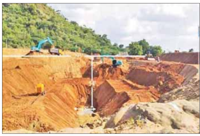
ညောင်ဦးခရိုင် ညောင်ဦးမြို့နယ် ဘောလုံးကျွန်းချောင်းမြေအောက်တစ် (Under Ground Dam) တည်ဆောက်ခြင်းလုပ်ငန်းကို တွေ့ရစဉ်။
