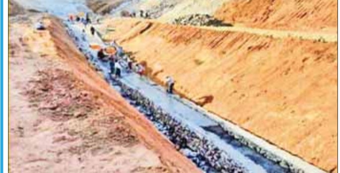
ညောင်ဦးခရိုင် ညောင်ဦးမြို့နယ် ဝါခင်းကြီးမြေအောက်တစ်ဖွားတည်ဆောက်ခြင်းလုပ်ငန်းခွင်မှ ကျောက်စီကွက်ကရစ်လောင်းခြင်းနှင့် Selected Soil ဖြင့် မြေဖြိုခြင်းလုပ်ငန်းကို တွေ့ရစဉ်။
