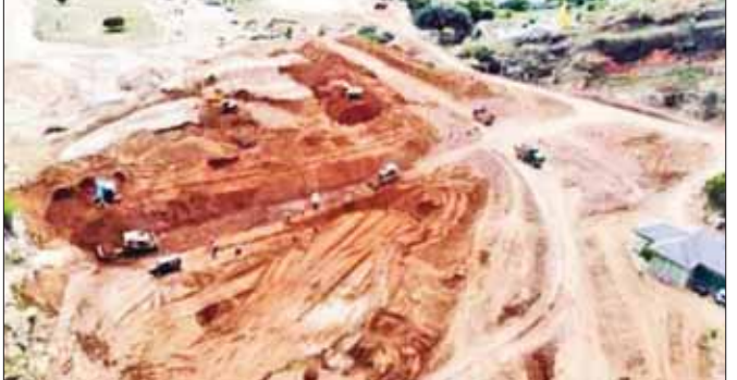
ညောင်ဦးခရိုင် ညောင်ဦးမြို့နယ် ဝါခင်းကြီးမြေအောက်တစ်ဖွားတည်ဆောက်ခြင်းလုပ်ငန်းခွင်မှ ကျောက်စီကွက်ကရစ်လောင်းခြင်းနှင့် Selected Soil ဖြင့် မြေဖြိုခြင်းလုပ်ငန်းကို တွေ့ရစဉ်။
