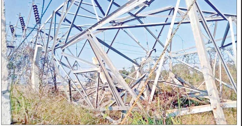
၁၃၂ ကေဗွီ ဘီလူးချောင်း(၂)- တီကျစ် ဓာတ်အားလိုင်း၏ တာဝါတိုင်များ ဖောက်ခွဲဖျက်ဆီးခံရမှုကြောင့် ပြိုလဲပျက်စီးခဲ့သည့် မှတ်တမ်းဓာတ်ပုံ။
