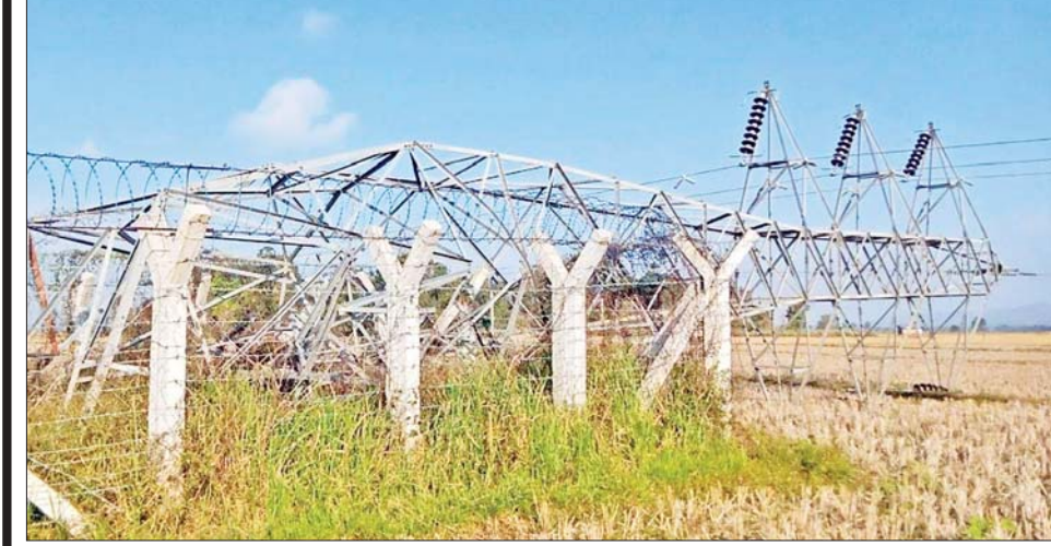
၁၃၂ ကေဗွီ ဘီလူးချောင်း(၂)- တီကျစ် ဓာတ်အားလိုင်း၏ တာဝါတိုင်များ ဖောက်ခွဲဖျက်ဆီးခံရမှုကြောင့် ပြိုလဲပျက်စီးခဲ့သည့် မှတ်တမ်းဓာတ်ပုံ။
