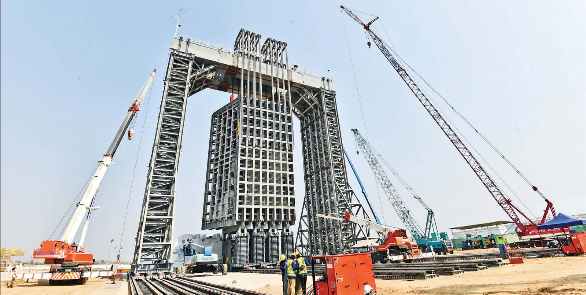
မာရဝိဇယဗုဒ္ဓရုပ်ပွားတော်မြတ်ကြီး၏ အစိတ်အပိုင်းကြီးအား ရတနာပလ္လင်တော်ထက်သို့ ပင့်ဆောင်ရေးလုပ်ငန်းများ ဆက်လက်ဆောင်ရွက်မှုကို တွေ့ရစဉ်။
