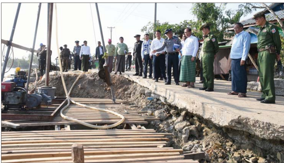
ရန်ပုံငွေဖြင့် ဆောင်ရွက်ခဲ့သည့် မေယုဝတီလမ်း ကျောက်ချော ခင်းခြင်း၊ စောပြည့်ညိုလမ်း ကွန်ကရစ်လမ်းခင်းခြင်း လုပ်ငန်း တို့ကို လှည့်လည်ကြည့်ရှုစစ်ဆေး နှင့် မြို့ပတ်လမ်း ကွန်ကရစ်ခင်း ခြင်းလုပ်ငန်း ဆောင်ရွက်ပြီးစီးမှု တင်ထွန်း(ပြန်/ဆက်)
