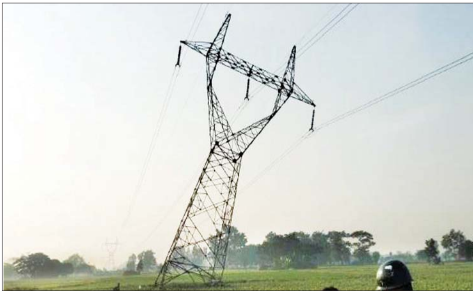
၂၀၂၃ ခုနှစ် ဇန်နဝါရီ ၁ ရက်တွင် ၂၃၀ ကေဗီ တောင်ငူ-သာယာကုန်း ဓာတ်အားလိုင်း ပဲခူးတိုင်းဒေသ ကြီး(အရှေ့ပိုင်း) ညောင်လေးပင်ခရိုင် ကျောက်တံခါးမြို့အနီးရှိ ဖောက်ခွဲဖျက်ဆီးခံရသည့် တာဝါတိုင် တိမ်းစောင်းနေမှုအခြေအနေ။
