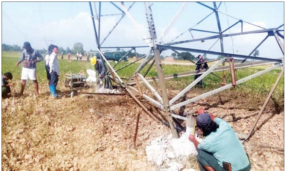
၂၀၂၃ ခုနှစ် ဇန်နဝါရီ ၁ ရက်တွင် ၂၃၀ ကေဗီ တောင်ငူ-သာယာကုန်း ဓာတ်အားလိုင်း ပဲခူးတိုင်းဒေသကြီး (အရှေ့ပိုင်း) ညောင်လေးပင်ခရိုင် ကျောက်တံခါးမြို့အနီးရှိ ဖျက်ဆီးခံရသည့် တာဝါတိုင်အား တာဝါတိုင် ဖြိုလဲမှုမဖြစ်စေရန် အရေးပေါ် ပြုပြင်နေပုံ။
