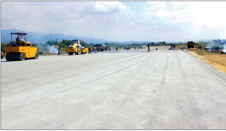
လေယာဉ်ပြေးလမ်း ကတ္တရာထပ်ပိုးလွှာခင်းကျင်းနေမှုကို တွေ့ရစဉ်။
