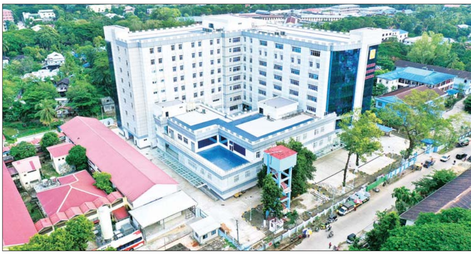
ပုသိမ်မြို့ ပြည်သူ့ဆေးရုံကြီး ကိုးထပ်ကုသဆောင်သစ်အဆောက်အအုံကို တွေ့ရစဉ်။
