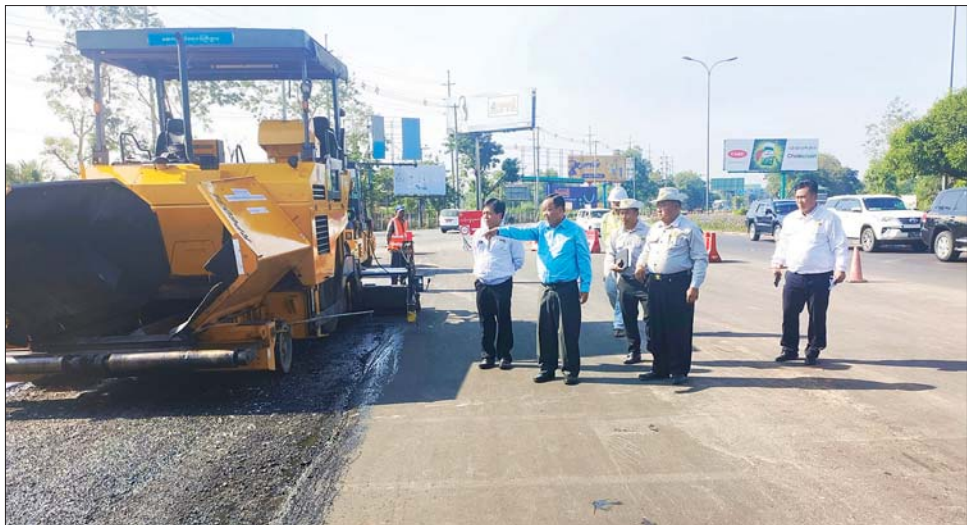
လမ်းခင်းပြီးစီးမှု လုပ်ငန်းများကို လမ်းတစ်လျှောက် ကြည့်ရှုစစ်ဆေးပြီး ပုသိမ် - ကံကုန်း - မြင်းကဆိပ်- မြောင်းမြလမ်းပေါ်၌ တံတားဦးစီးဌာန တံတားအထူး အဖွဲ့(၁၅)က တာဝန်ယူ ဆောက်လုပ်နေသည့် ပမ္မဝတီတံတား (မြင်းကဆိပ်) အဆင့်မြှင့်တင် တည်ဆောက်ခြင်းစီမံကိန်း ရှင်းလင်းဆောင်သို့ ရောက်ရှိရာ စီမံကိန်းတာဝန်ခံ ဒုတိယညွှန်ကြား ရေးမှူး (မြို့ပြ) ဦးကျော်မိုးဦးက စီမံကိန်းဆောင်ရွက်နေမှု အခြေအနေများ ရှင်းလင်းတင်ပြမှုအပေါ် ဒုတိယ ဝန်ကြီးက စီမံကိန်းအတွက်လိုအပ်သည့် ရန်ပုံငွေ ရရှိမှု၊ ပစ္စည်းဝယ်ယူမှုအခြေအနေများ၊ မြေယာ လျော်ကြေးဆိုင်ရာကိစ္စရပ်များ ဆောင်ရွက်မှုများကို လုပ်ထုံးလုပ်နည်းနှင့်အညီ ဆောင်ရွက်ရန် မှာကြား ကြောင်း သတင်းရရှိသည်။ သတင်းစဉ်
