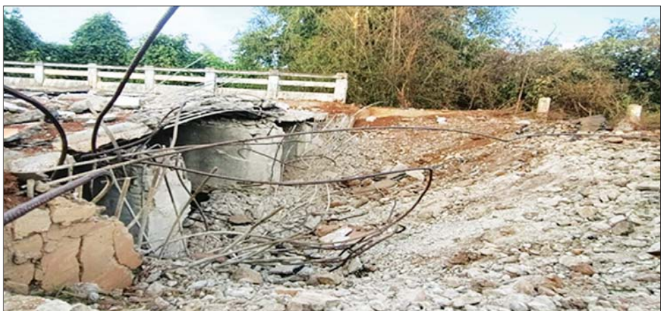
ရွှေကျင် - ကျောက်ကြီးသွားကားလမ်းပေါ်ရှိ သရက်ချောင်း ချောင်းကူးတံတားအား PDF အမည်ခံ အကြမ်းဖက်သမားများက မိုင်းထောင်ဖောက်ခွဲဖျက်ဆီးထားမှုကို တွေ့ရစဉ်။
