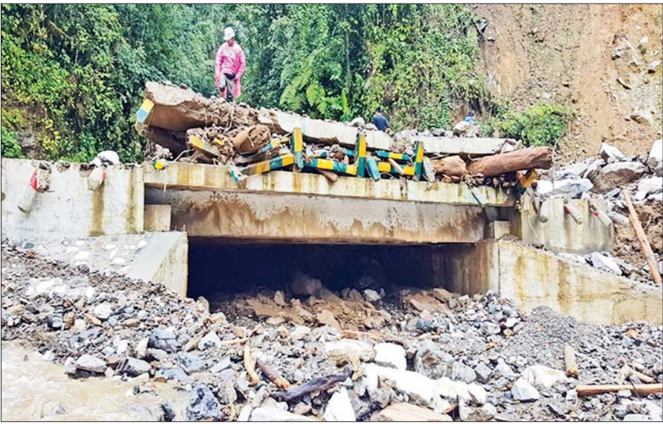
ကချင်ပြည်နယ် မဝေဇ-ခေါင်လမ်းဖူး ကားလမ်းပေါ်မှ တံတားတစ်စင်း ချောင်းရေတိုက်စား၍ ပျက်စီးမှုမှတ်တမ်းဓာတ်ပုံ။
