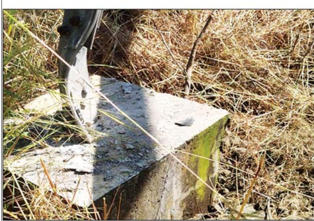
မသမာသူများ၏ ဖောက်ခွဲဖျက်ဆီးခံမှုကြောင့် ၂၃၀ ကေဗီ မင်းဘူး (မန်း) - အမ်း ဓာတ်အားလိုင်း တာဝါတိုင်အမှတ် (၉၄) ဖောက်ခွဲ ဖျက်ဆီးခံရမှု မှတ်တမ်းဓာတ်ပုံ။
