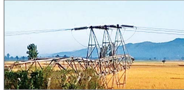
၁၃၂ ကေဗီ ဘီလူးချောင်း (၂) - တီကျစ် နှစ်ထပ်ဓာတ်အားလိုင်း တာဝါတိုင်အမှတ်(၁၁၁) ဖောက်ခွဲဖျက်ဆီးခံရသည့် မှတ်တမ်းဓာတ်ပုံ။
