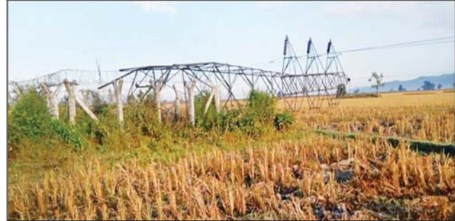
၁၃၂ ကေဗီ ဘီလူးချောင်း (၂) - တီကျစ် နှစ်ထပ်ဓာတ်အားလိုင်း တာဝါတိုင်အမှတ်(၁၁၀) ဖောက်ခွဲဖျက်ဆီးခံရသည့် မှတ်တမ်းဓာတ်ပုံ။
