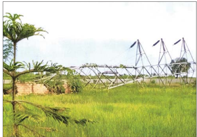
၁၃၂ ကေဗီ ဘီလူးချောင်း (၂) - တီကျစ် နှစ်ထပ်မဟာဓာတ်အားလိုင်း တာဝါတိုင်အမှတ် (၁၃၀) ဖောက်ခွဲဖျက်ဆီးခံရမှု (ဝဲပုံ) နှင့် ပြန်လည် တည်ဆောက်ပြီးစီးသည့် မှတ်တမ်းဓာတ်ပုံ (ယာပုံ)။
