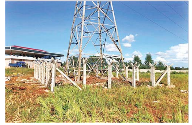
၁၃၂ ကေဗီ ဘီလူးချောင်း (၂) - တီကျစ် နှစ်ထပ်မဟာဓာတ်အားလိုင်း တာဝါတိုင် အမှတ် (၁၃၀) မိုင်းခြံရိုးကာရံခြင်း ဆောင်ရွက်ပြီးစီးသည့် မှတ်တမ်းဓာတ်ပုံ။
