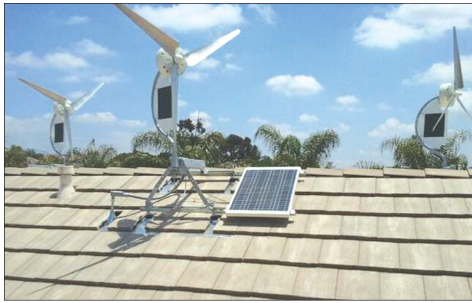
မဟာဓာတ်အားလိုင်းနှင့်ဝေးသောနေရာများ၌ အသုံးပြုသင့်သည့် ဆိုလာနှင့် လေအားနှစ်မျိုးသုံး Hybrid Energy System ။
