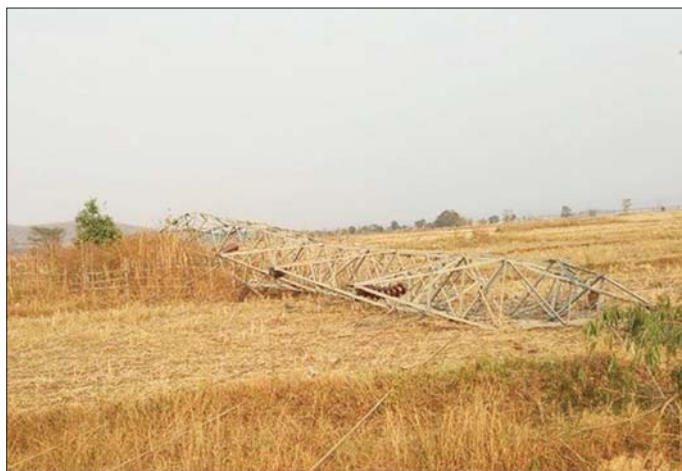
၂၃၂ ကေဗီ ဘီလူးချောင်း(၂)- တီကျစ်ဓာတ်အားလိုင်းအား ဖျက်ဆီးထားရှိမှုကို တွေ့ရစဉ်။
