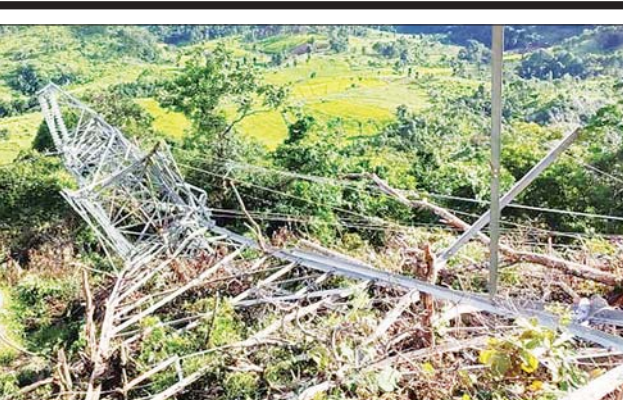
၂၃၀ ကေစီဘလေ(၂)-ရွှေမြို့ ဓာတ်အားလိုင်း တာဝါတိုင်အမှတ်(၁၆၄) အား ဖျက်ဆီးထားရှိမှုကို တွေ့ရစဉ်။
