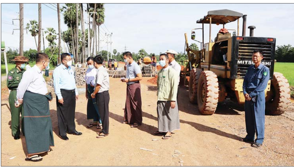
ခြင်း လုပ်ငန်းဆောင်ရွက်နေမှု အခြေအနေကို ကြည့်ရှုစစ်ဆေး သည်။(အပေါ်ပုံ) ထိုသို့ ကြည့်ရှုစစ်ဆေးစဉ် ကျေးလက်လမ်း ဖွံ့ဖြိုးရေးဦးစီး ဌာန ပြည်နယ်ဦးစီးမှူးက လမ်း အရှည် ပတ္တလူးကုန်း ရွာအဝင် လမ်းအား မော်လမြိုင်- ကျိုက် မရော လမ်းမကြီးနှင့် ချိတ်ဆက် ဖောက်လုပ်ထားရှိမှု ၂၀၂၂-၂၀၂၃ ဘဏ္ဍာရေးနှစ်တွင် ပြည်နယ် ခွင့်ပြုရန်ပုံငွေကျပ် ၁၈၇ ဒသမ ၉ သန်းဖြင့် မူလလမ်း အကျယ် ၁၂ပေမှ ၂၄ ပေ အကျယ် (၀/ ၆ မိုင်) ကတ္တရာလမ်း တိုးချဲ့ အဆင့်မြှင့်တင် ဖောက်လုပ်ခြင်း လုပ်ငန်း ဆောင်ရွက်နေမှုကို ရှင်းလင်းတင်ပြရာ ပြည်နယ် ဝန်ကြီးချုပ်က လမ်းအရည် အသွေး ပြည့်မီစေရေး၊ သတ်မှတ် ကာလအတွင်း အချိန်မီပြီးစီး
