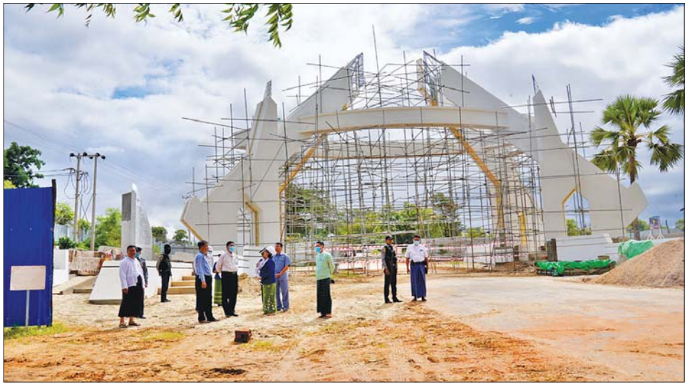
လမ်းခင်းခြင်းနှင့်အကျယ် ၄၈ ပေ၊ အရှည်ပေ ၁၀၀၀ ရိုးရိုးကတ္တရာလမ်းခင်းခြင်းလုပ်ငန်းကို ဆောင်ရွက်လျက်ရှိပြီး အဆိုပါလုပ်ငန်းအားလုံးကို ယခု ဩဂုတ်လအတွင်း ပြီးစီးအောင် ဆောင်ရွက်သွားမည်ဖြစ်ကြောင်း တာဝန်ခံအင်ဂျင်နီယာမှူးထံမှ သိရသည်။
