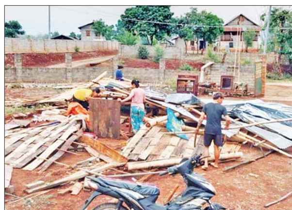
လေပြင်းတိုက်မှုကြောင့် ထိခိုက်ပျက်စီးမှုများကို ရှင်းလင်း ဆောင်ရွက်နေစဉ်။
