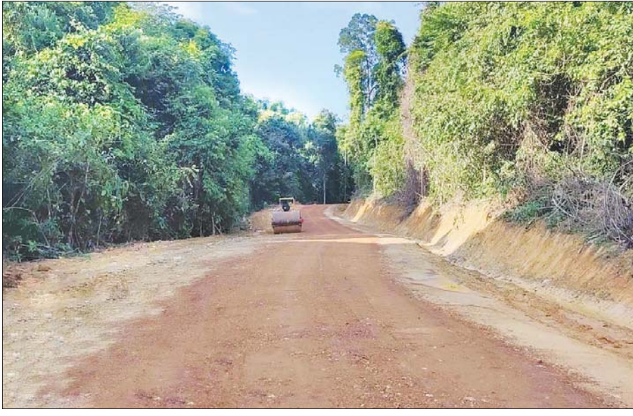
ကော့သောင်းမြို့နယ် ဇာဒက်ကြီးကျွန်းပတ်လမ်း ၆၆/၀ မိုင်အနက် ၂/၀ မိုင် ကျောက်ခင်းခြင်းလုပ်ငန်း ဆောင်ရွက်ပြီးစီးမှုကို တွေ့ရစဉ်။
