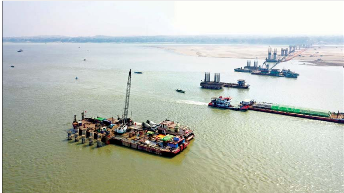
ဧရာဝတီတံတား(သရက် - အောင်လံ) တည်ဆောက်ရေးလုပ်ငန်းခွင်ကို တွေ့ရစဉ်။
