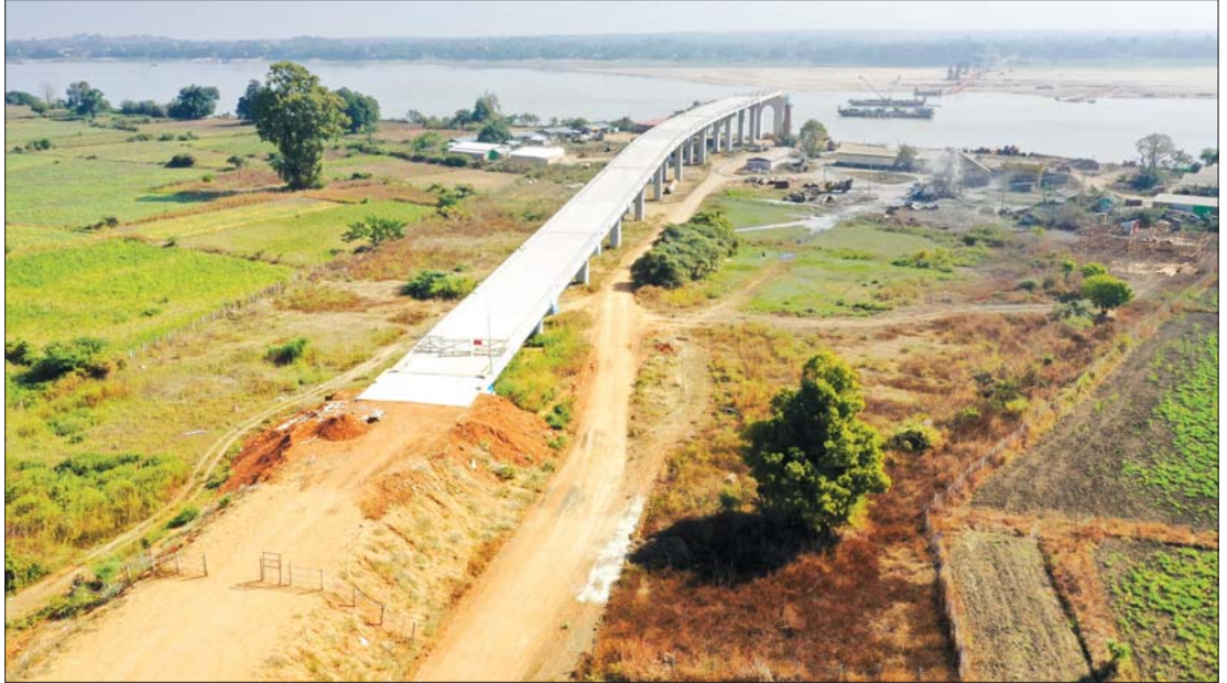
ဧရာဝတီတံတား(သရက် - အောင်လံ) တံတားချဉ်းကပ်လမ်း တည်ဆောက်ပြီးစီးမှုကို တွေ့ရစဉ်။
