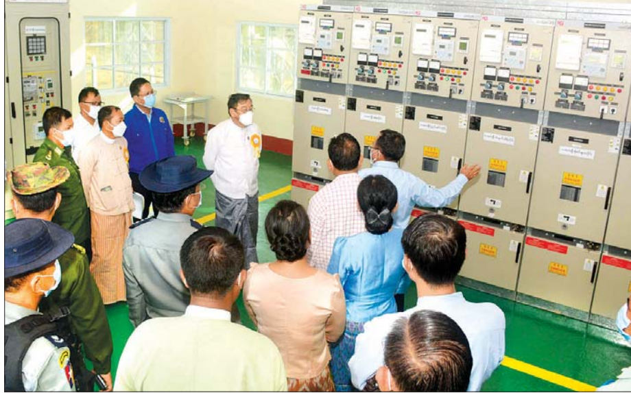
၂၀၂၂-၂၀၂၃ ဘဏ္ဍာနှစ်တွင် ဓာတ်အားလိုင်း၊ ဓာတ်အား ခွဲရုံများ တည်ဆောက်ပြီးစီးပါက ကနက်သီရိ၊ ကွဲမင်း ကုန်း၊ ပိန္နဲကုန်း၊ ချောင်းဝပြင်၊ သဲချောင်းသား၊ မင်းဒပ်၊ ဝဲရစ်၊ သစ်တိုကုန်း၊ သိမ်ကုန်း၊ အင်ဗူး၊ ကျောက် ခမောက်၊ စုံစင်ကျေးရွာများလည်း ဓာတ်အားရရှိ မည်ဖြစ်ပြီး ကျန်ကျေးရွာများဓာတ်အားရရှိရေး အတွက် ၂၀၂၃-၂၀၂၄ ဘဏ္ဍာနှစ်တွင် တိုင်းဒေသကြီး ရန်ပုံငွေဖြင့် ဆက်လက် ဆောင်ရွက်ပေးမည်ဖြစ် ကြောင်း သိရသည်။ တိုင်းဒေသကြီး (ပြန်/ဆက်)
