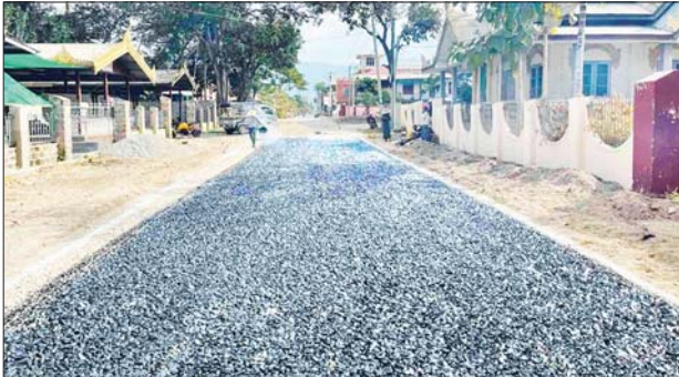
ညောင်ရွှေမြို့နယ် စည်ပင်သာယာရေးဌာန၏ ၂၀၂၁-၂၀၂၂ ဘဏ္ဍာ ရေးနှစ် ခြောက်လတာကာလ ခွင့်ပြုရန်ပုံငွေဖြင့် လမ်းအရှည် ပေ ၅၀၀၊ အကျယ် ၁၈ ပေရှိ ဖောင်တော်ဆိုက်လမ်း ကတ္တရာ ထပ်ပိုးလွှာခင်းခြင်းလုပ်ငန်း ဆောင်ရွက်နေမှုကို မတ် ၁၈ ရက်က အငယ်တန်း အင်ဂျင်နီယာ (၂) ဒေါ်အိအိဖြိုး ကြီးကြပ်ဆောင် ရွက်စဉ်။ နေမျိုးသူရန်
