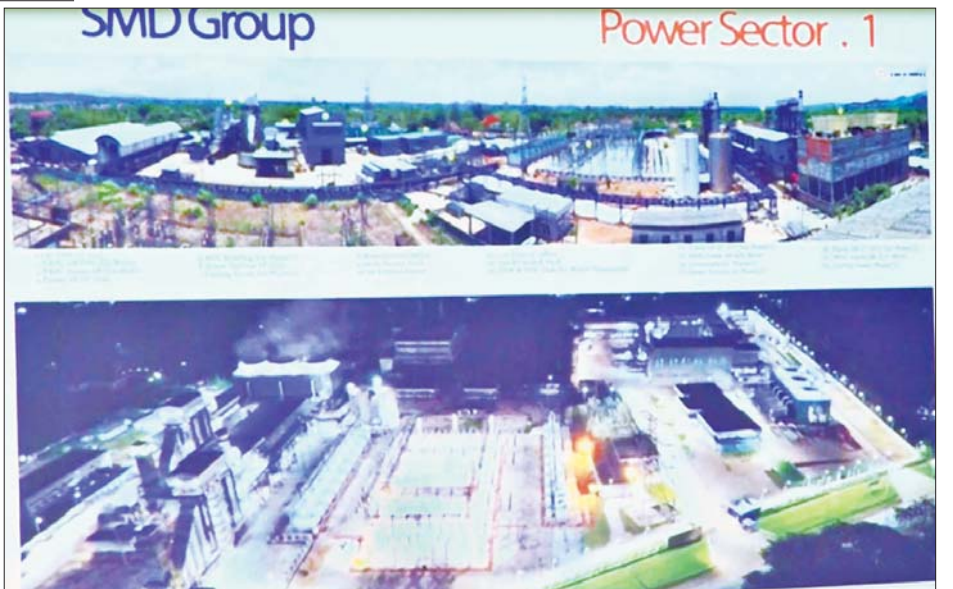
မော်လမြိုင်မြို့ Myanmar Lighting (IPP) Power Plant ဓာတ်အားပေးစက်ရုံပုံစံကို တွေ့ရစဉ်။
